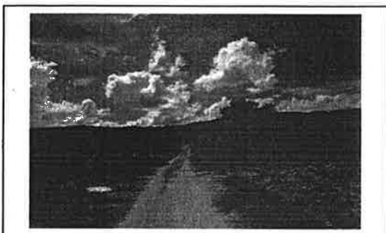
กม. ...๐.....๑๗๐..... (สภาพสายทางโดยทั่วไป)
