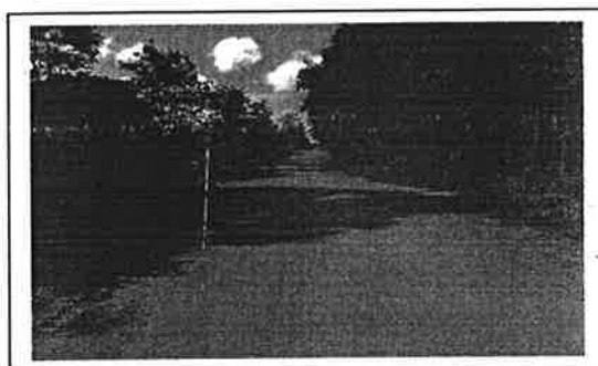
กม. ...๒+๐๐๐.....๑๐๐..... (สภาพสายทางโดยทั่วไป)
