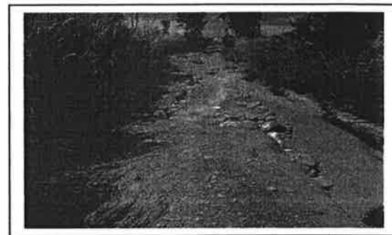
กม. ...๐...+...๖๘๐..... (สภาพสายทางโดยทั่วไป)
