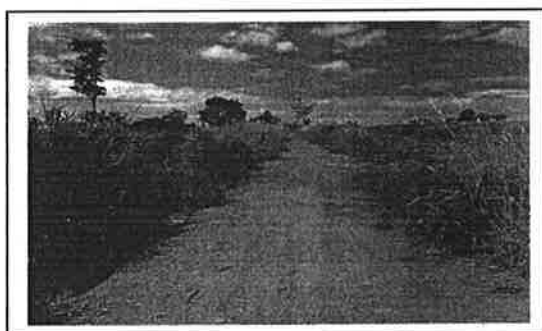
กม. ...๑...+...๐๐๐..... (สภาพสายทางโดยทั่วไป)
