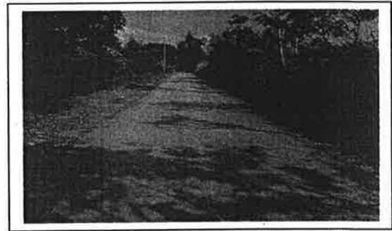
กม. ...๐+๐๐๐.....๑๖๐..... (สภาพสายทางโดยทั่วไป)
